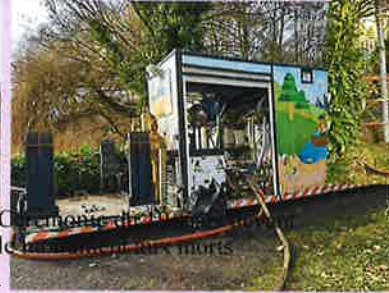
Fonçage sous la rivière en décembre 2021 pour passer une gaine pour
